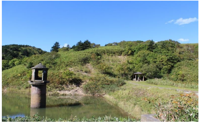
・ロングコース内にある旧貯水池
